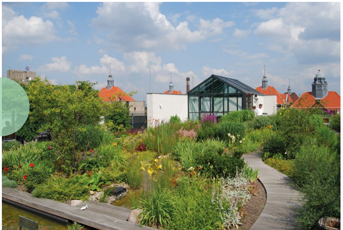
Intensives Gründach auf einem Gebäude der Wiegmann Klinik in Berlin. Der Dachgarten ist für Patientinnen und Patienten Therapie-, Rückzugs- und Erholungsort gleichermaßen.
